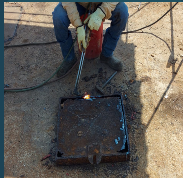
Trabajos de metalmecanica
