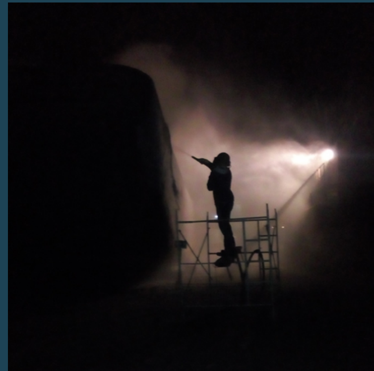
Sandblasting y Wetblasting
