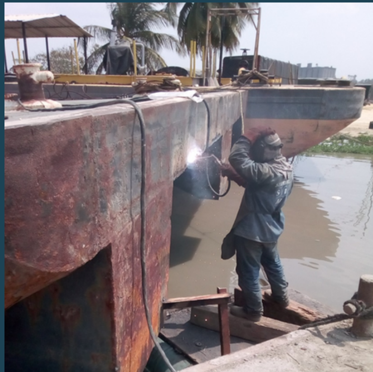
Aplicacion de soldadura
